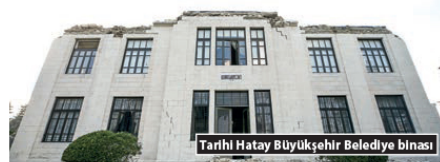
Tarihî Hatay Büyükşehir Belediye Binası
