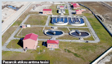
Pazarcık atıksu arıtma tesisi
