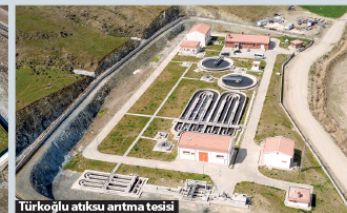
Türkoglu atıksu arıtma tesisi
