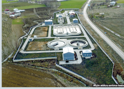
Afşin atıksu arıtma tesisi
