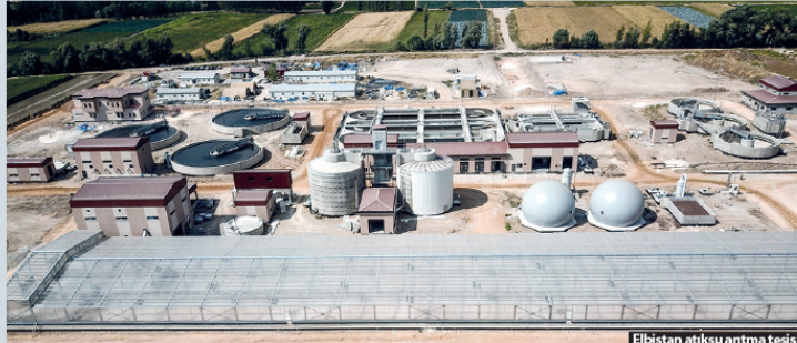
Elbistan atıksu arıtma tesisi
